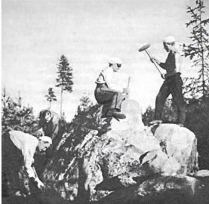
Salpalinjan kiviasteiden louhintaa kesällä 1940. (SA-kuva)
