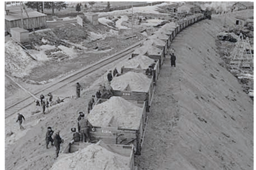
Junaradan rakentaminen Kemijärveltä Sallaan kuului Moskovan rauhansopimuksen ehtoihin. Kuva radan rakennustyömaalta Kemijärveltä 1941. (SA-kuva)
